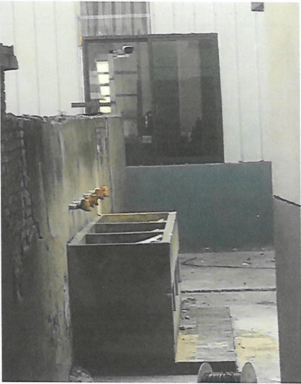
图 3-6 危废仓库外部监控
