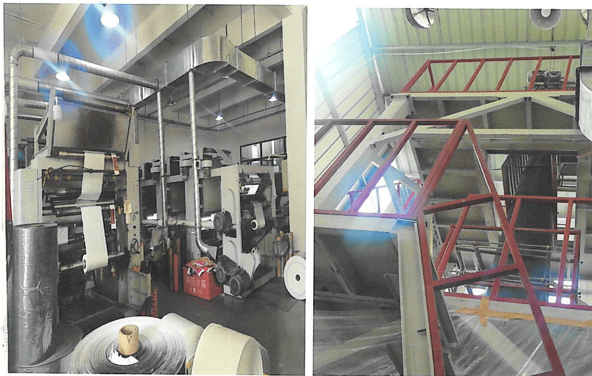
图 3-1 车间内部集气装置
